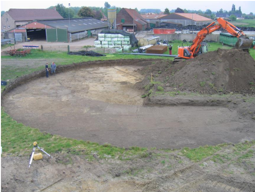
Fig. 9: Zicht op het uitgraven van de mestilo.
