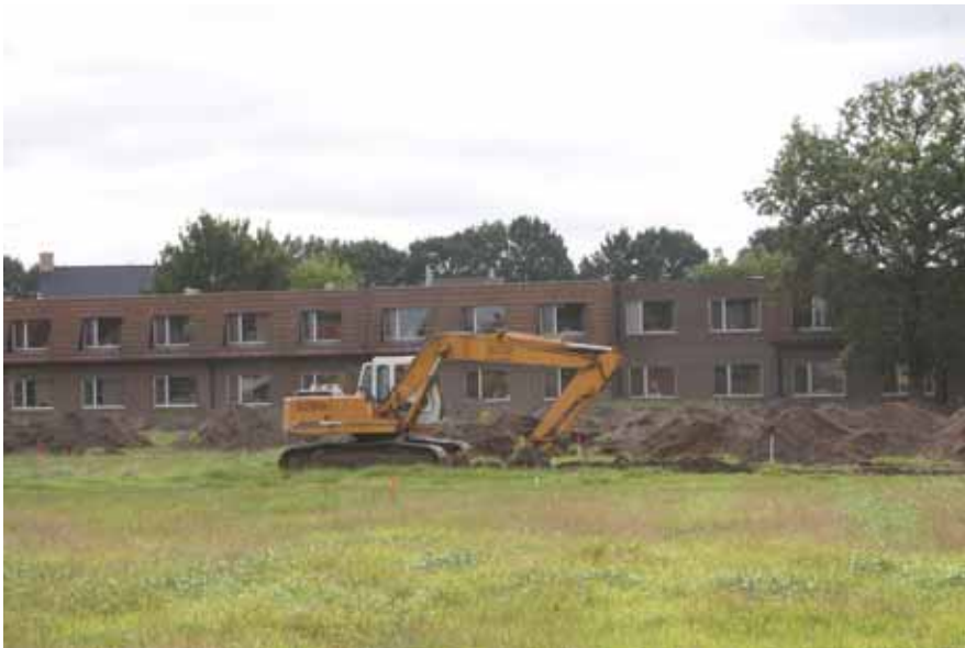
Figuur 4.1. Aanleg van de proefsleuven met op de achtergrond de huidige home.
