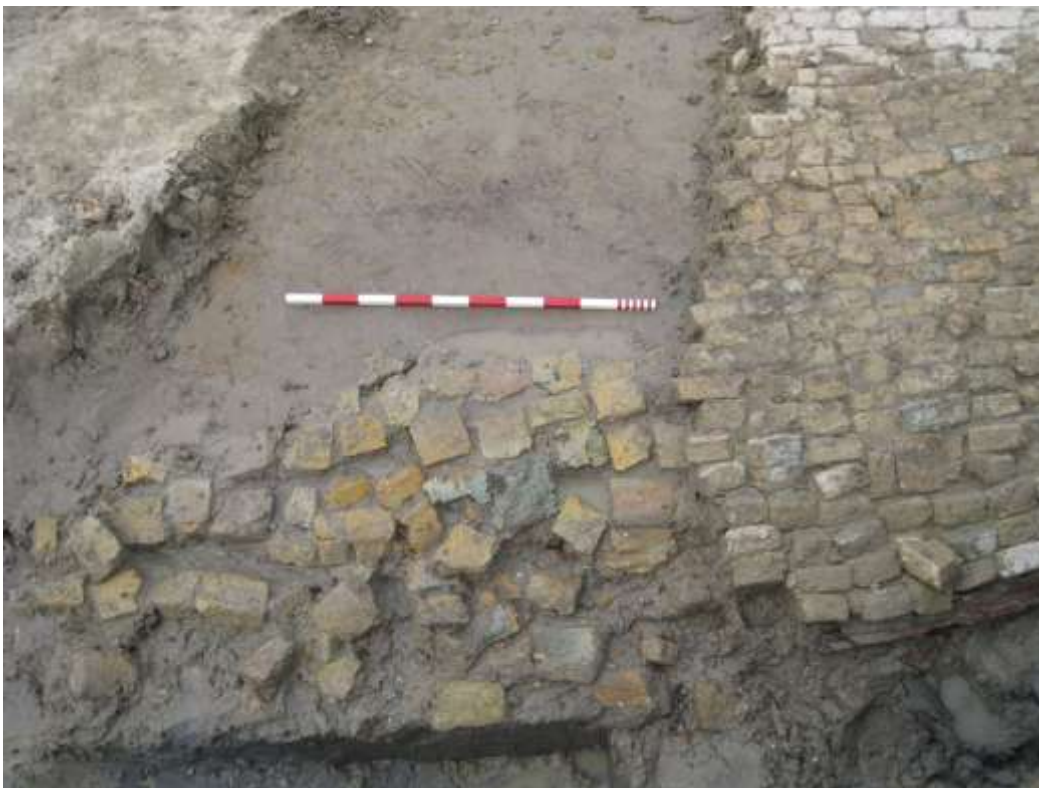
Figuur 19: extra ondersteuning onderaan met laag baksteenbrokken.
