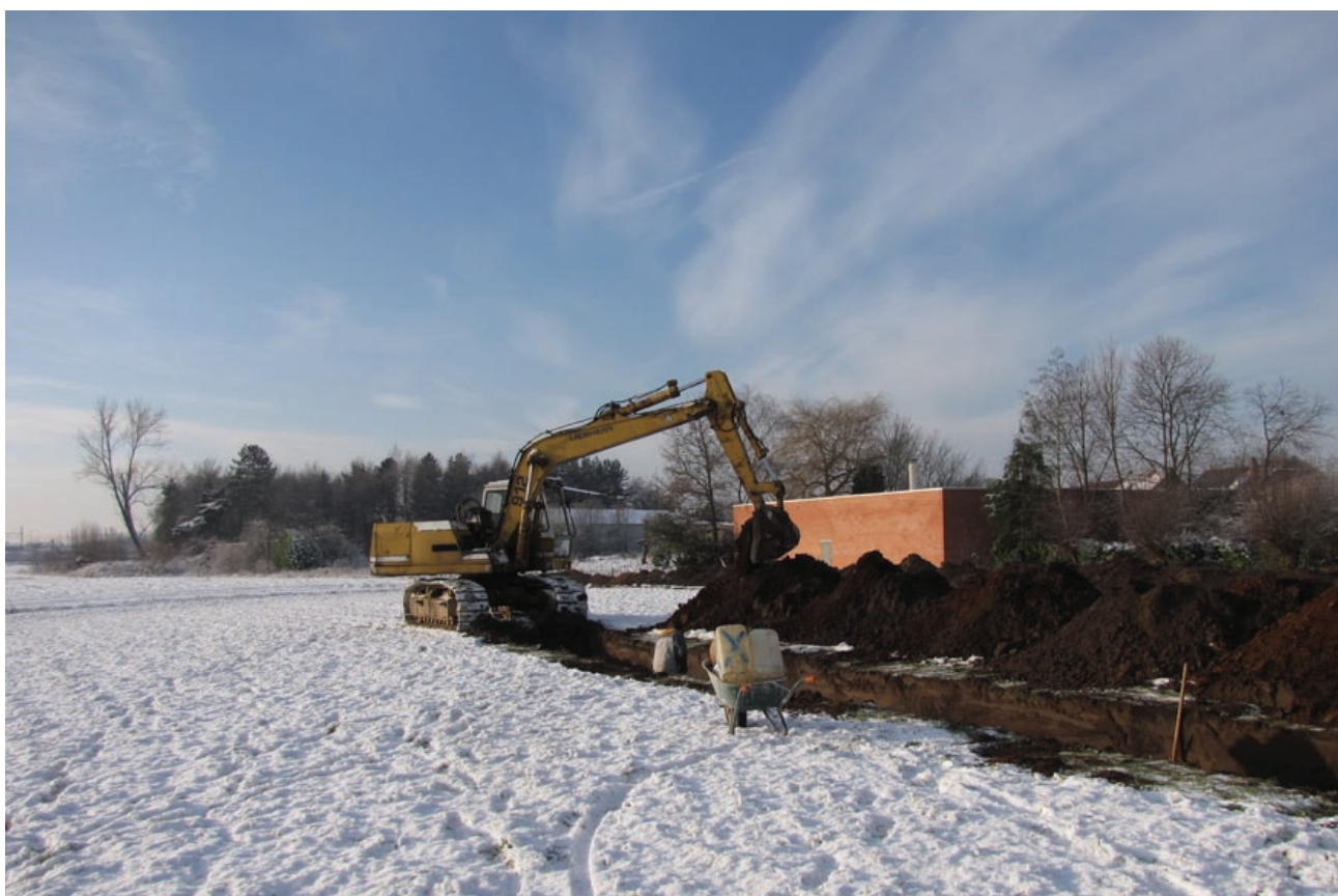
afb. 33: Aanleg van de proefsleuven.
