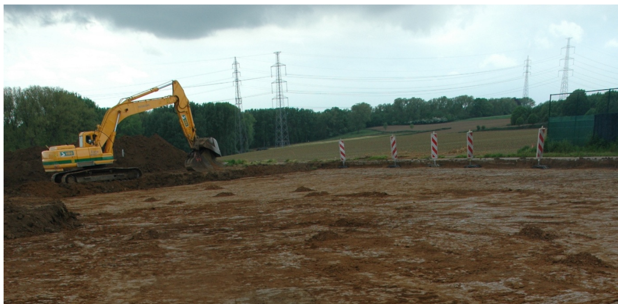
Fig. 4: Zicht op de graafwerken in werkput 1.
