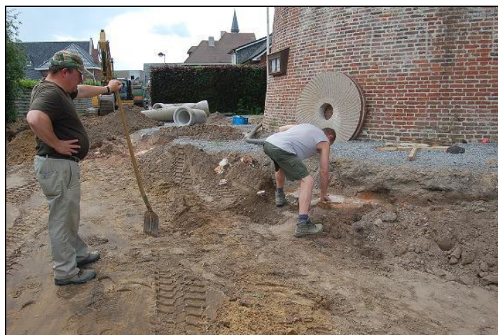
Fig.10: Bijkomende funderingen in baksteen na het gedeeltelijk opkuisen van de wegkoffer.
