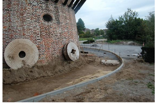
Fig. 30: De borduurstenen netjes geplaatst rond de funderingspijlers.
