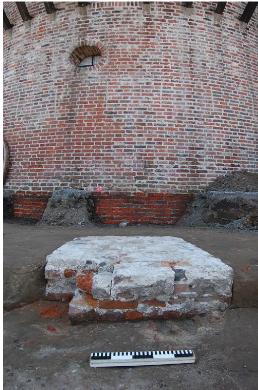
Fig. 20: Pijlerfundering (spoor 3) met de aansluitende intanding in het molenlichaam.
