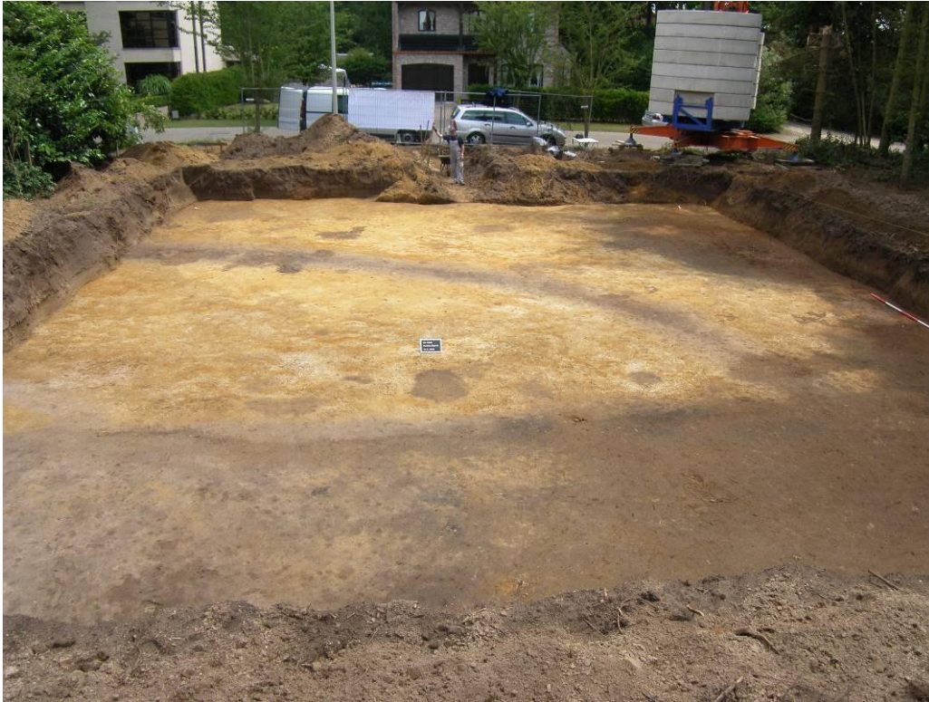
Fig. 8 Overzichtsfoto van de bouwput. Foto in noordoostelijke richting.
