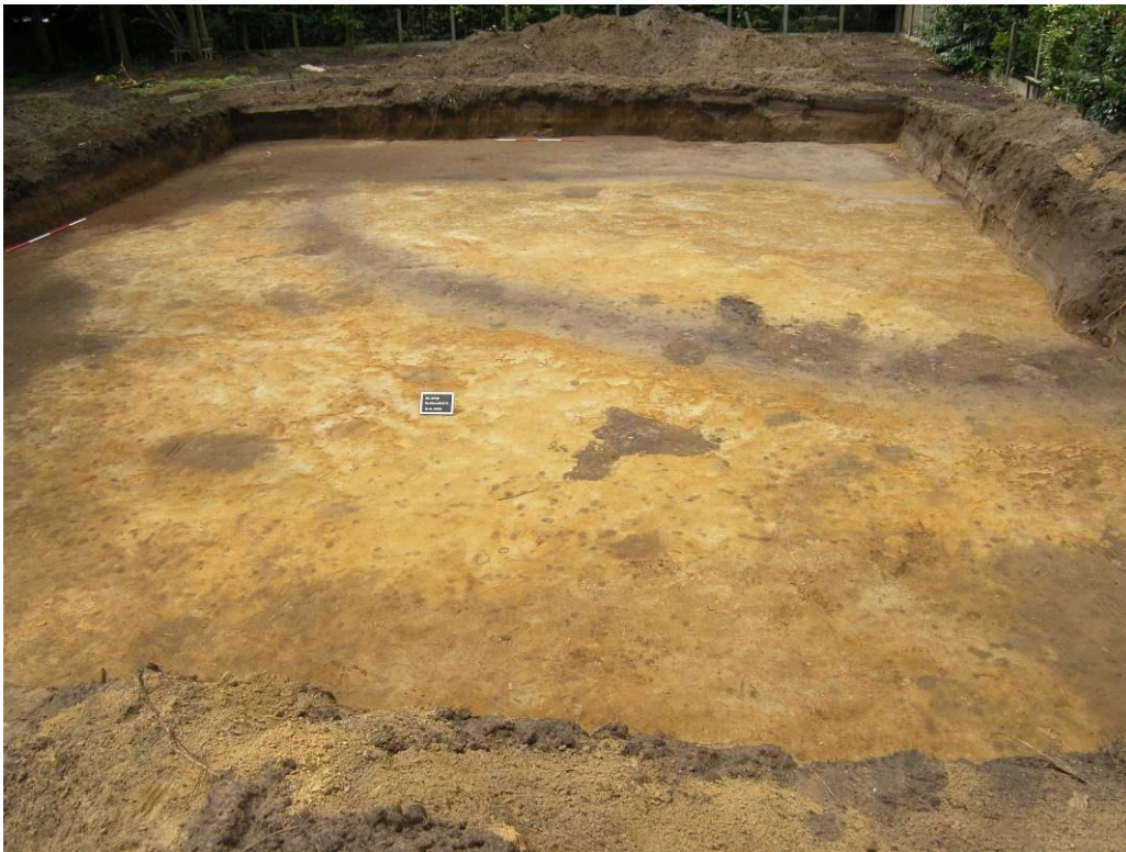
Fig. 9 Overzichtsfoto van de bouwput. Foto in zuidwestelijke richting.
