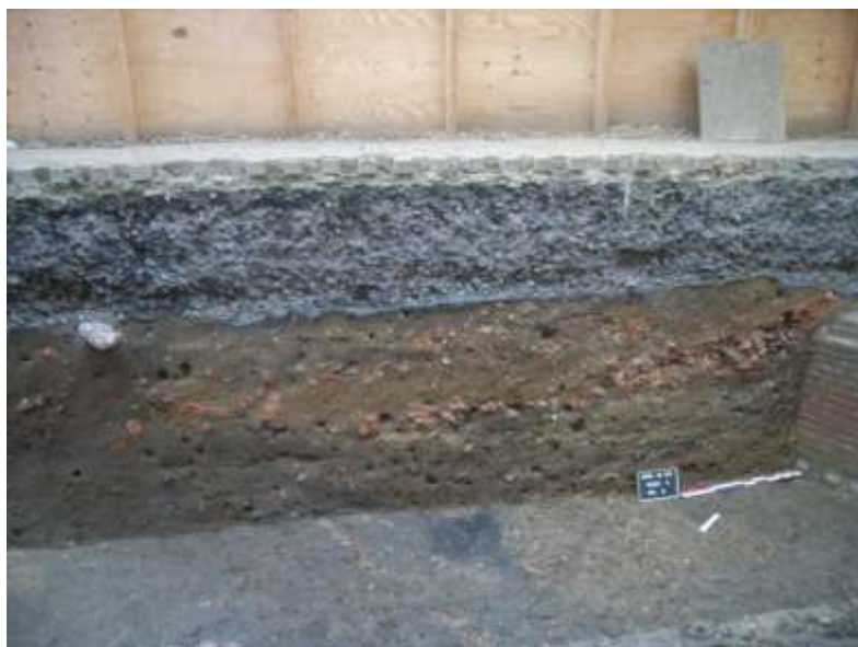
Fig. 29 Sleuf II noordprofiel: de verschillende ophogingslagen van het Walgrachtstraatje, aansluitend tegen de bakstenen muur.
