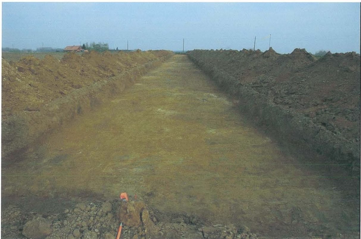
Fig. 6: De opgravingsleuf vanuit het oosten
