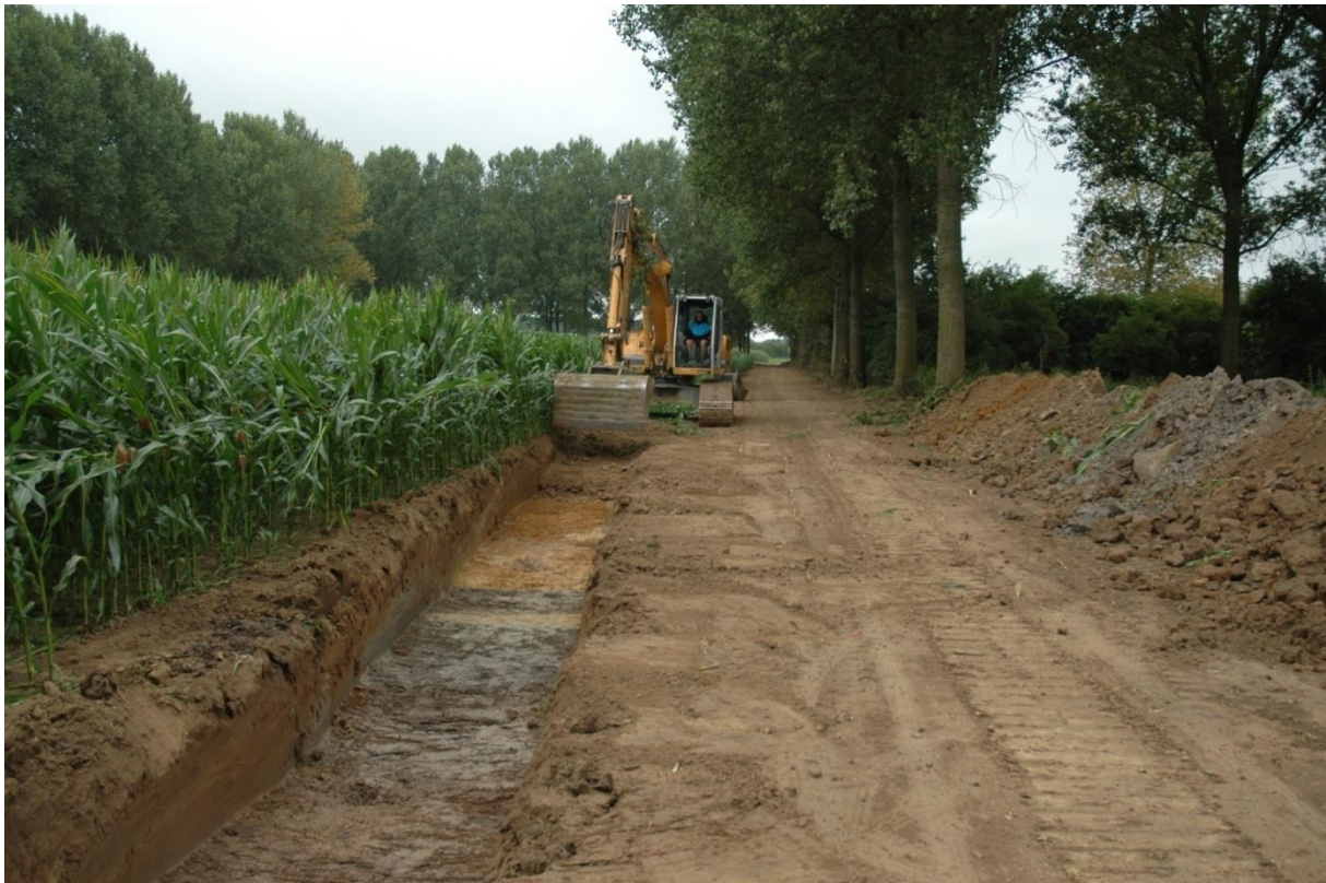
Fig. 5: Aanleg van een proefsleuf in zone 1.
