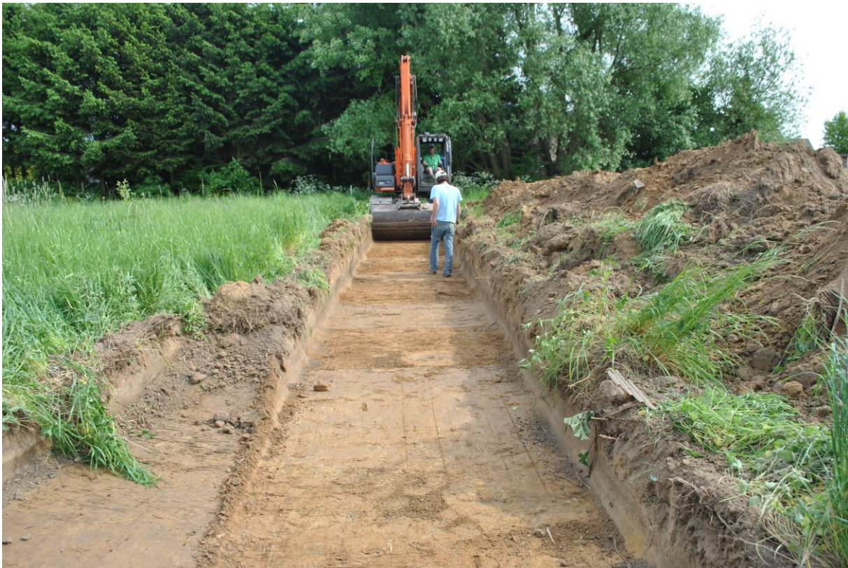
Fig. 10: Het graven van de proefsleuven.
