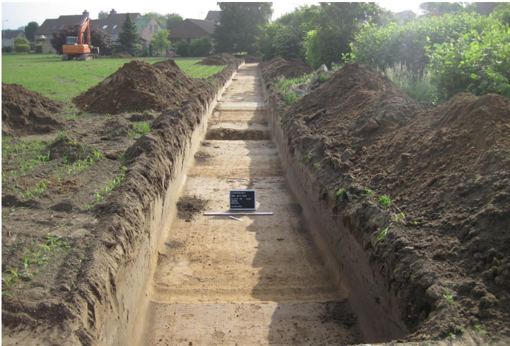
Fig. 9: Het graven van de proefsleuven.
