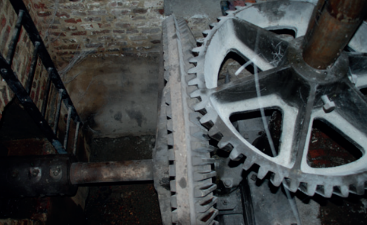
▲ In de asput of "hel". Overbrenging van verticaal aswiel op horizontaal maalwiel.
