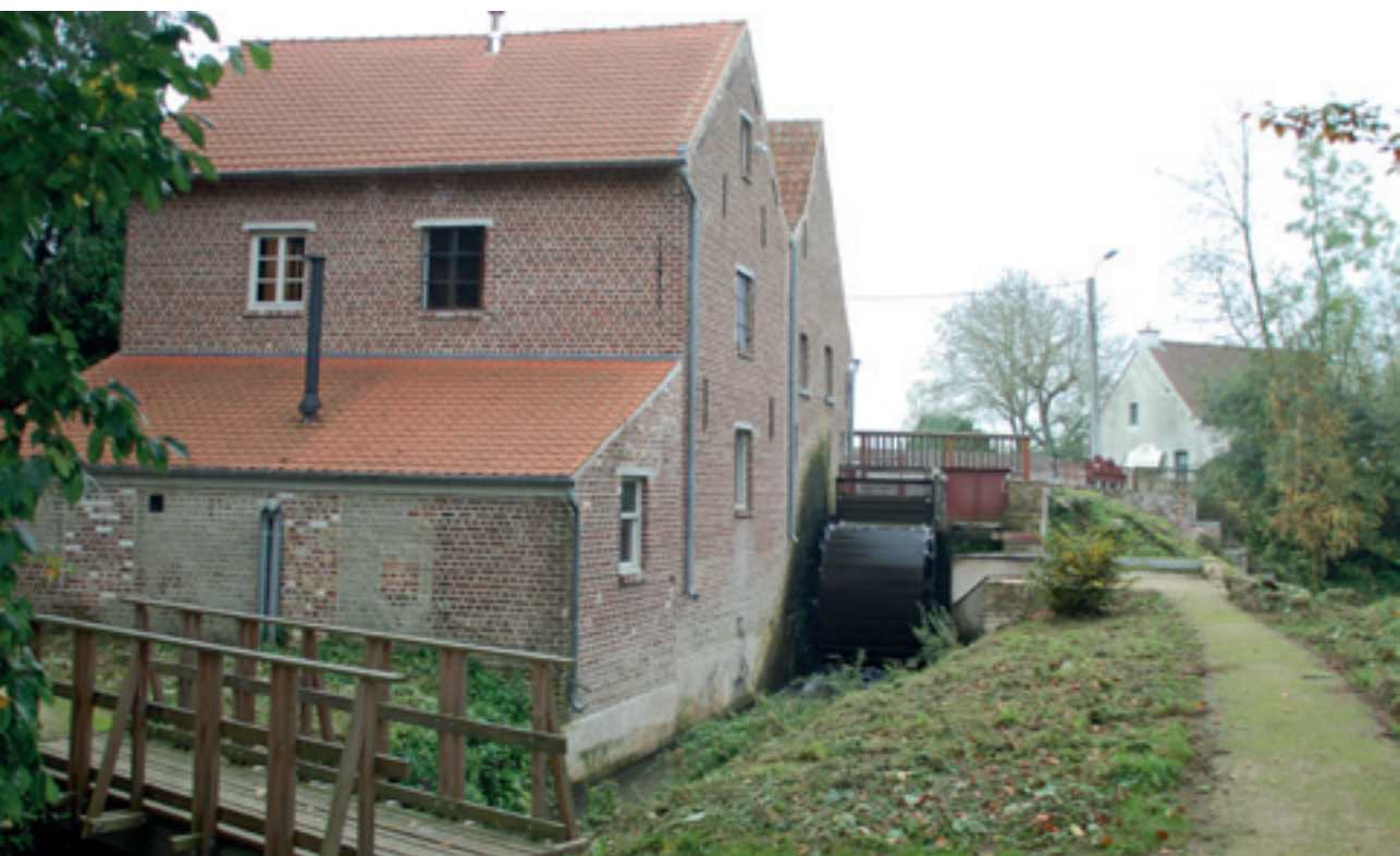
▲ Zwalmolen, westzijde. Molengebouw onder twee evenwijdige zadeldaken en aanbouw onder lessenaarsdak bevatten in volgorde: de machinekamer met dieselmotor, de cilindermaalderyn en de klassieke graanmolen (toestand 2011).
