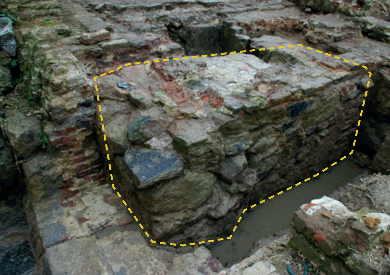
▲ Het rechthoekige massieve blok metselwerk.
