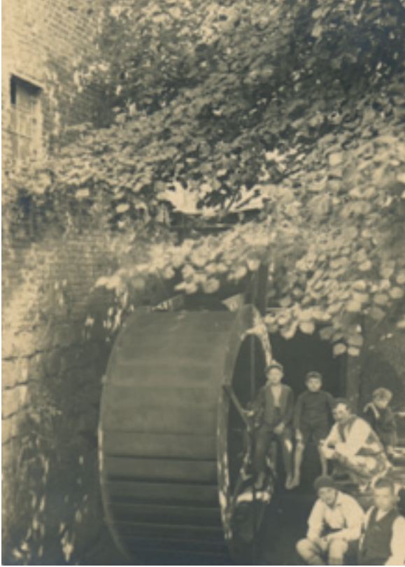
◀ Fotografische opname "Munckzwalm september 1928". Watergevel nog halfopgemetseld met natuursteen.
