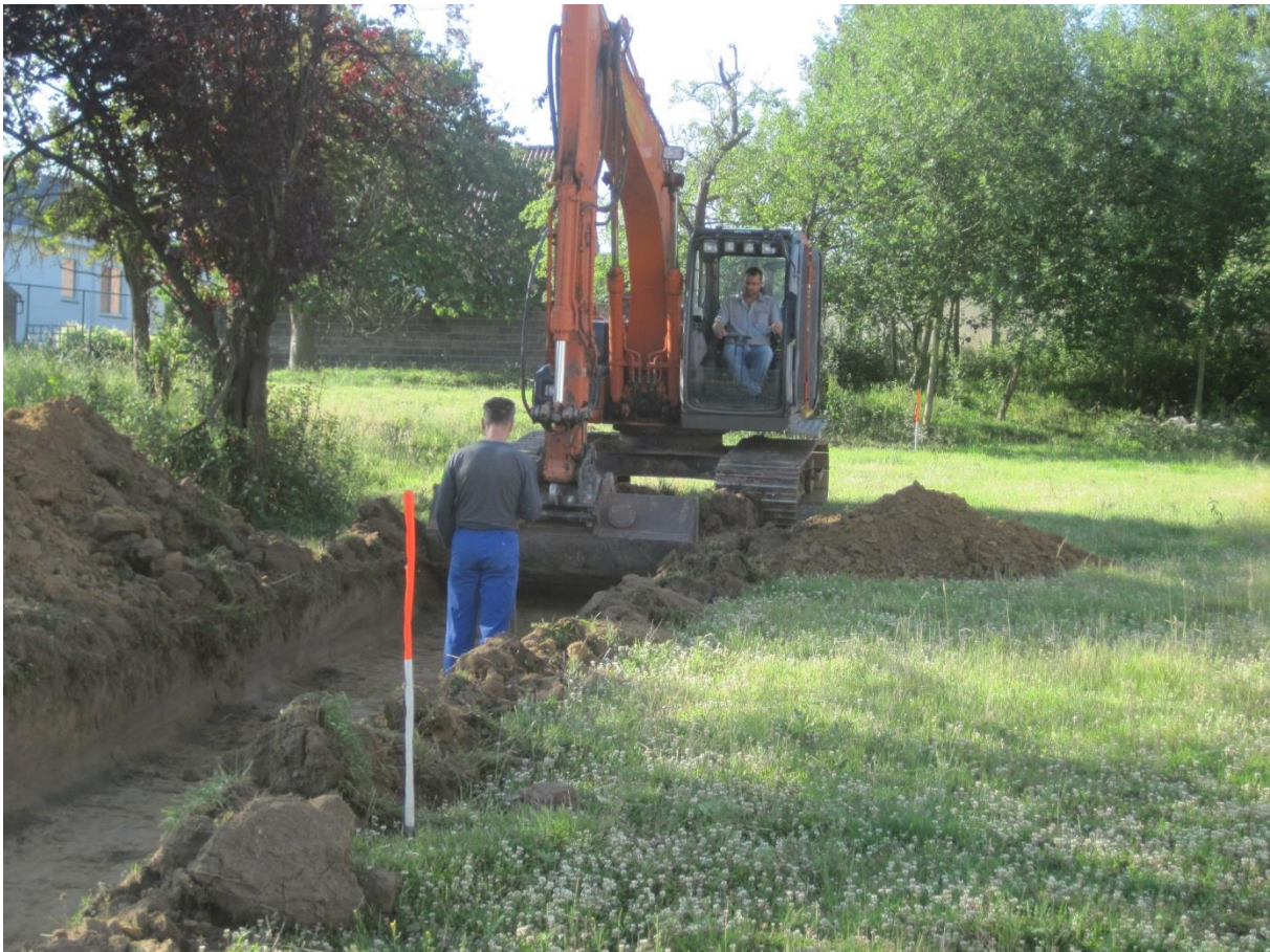
Fig. 8: Het graven van de proefsleuven.
