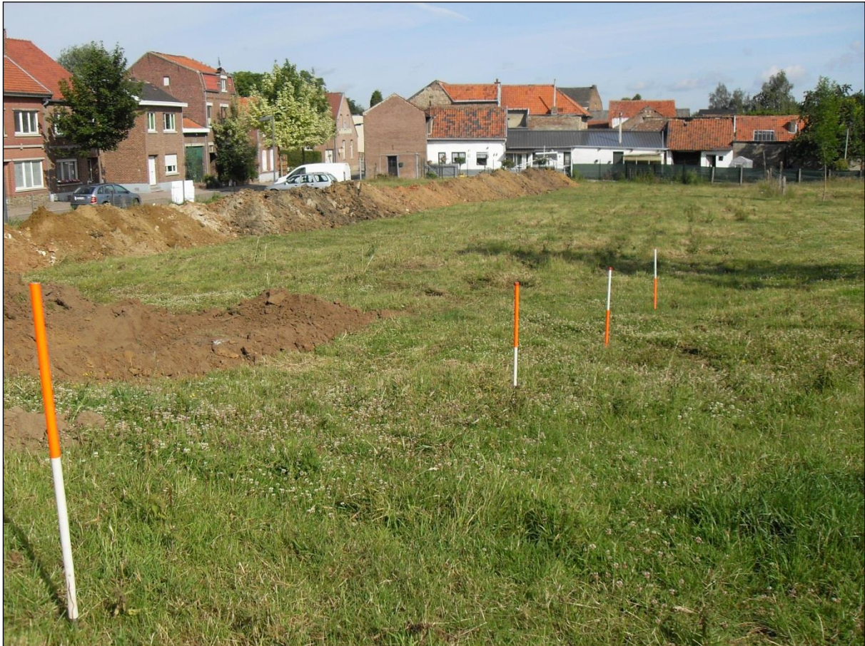
Fig. 6: Zicht op het talud richting noordwesten.
