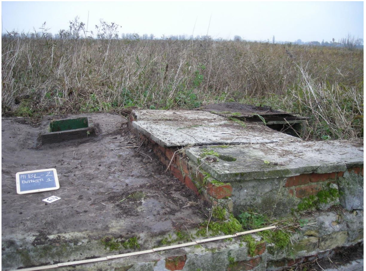
Fig. 31 Zicht op de jachtbunker voor afbraak
