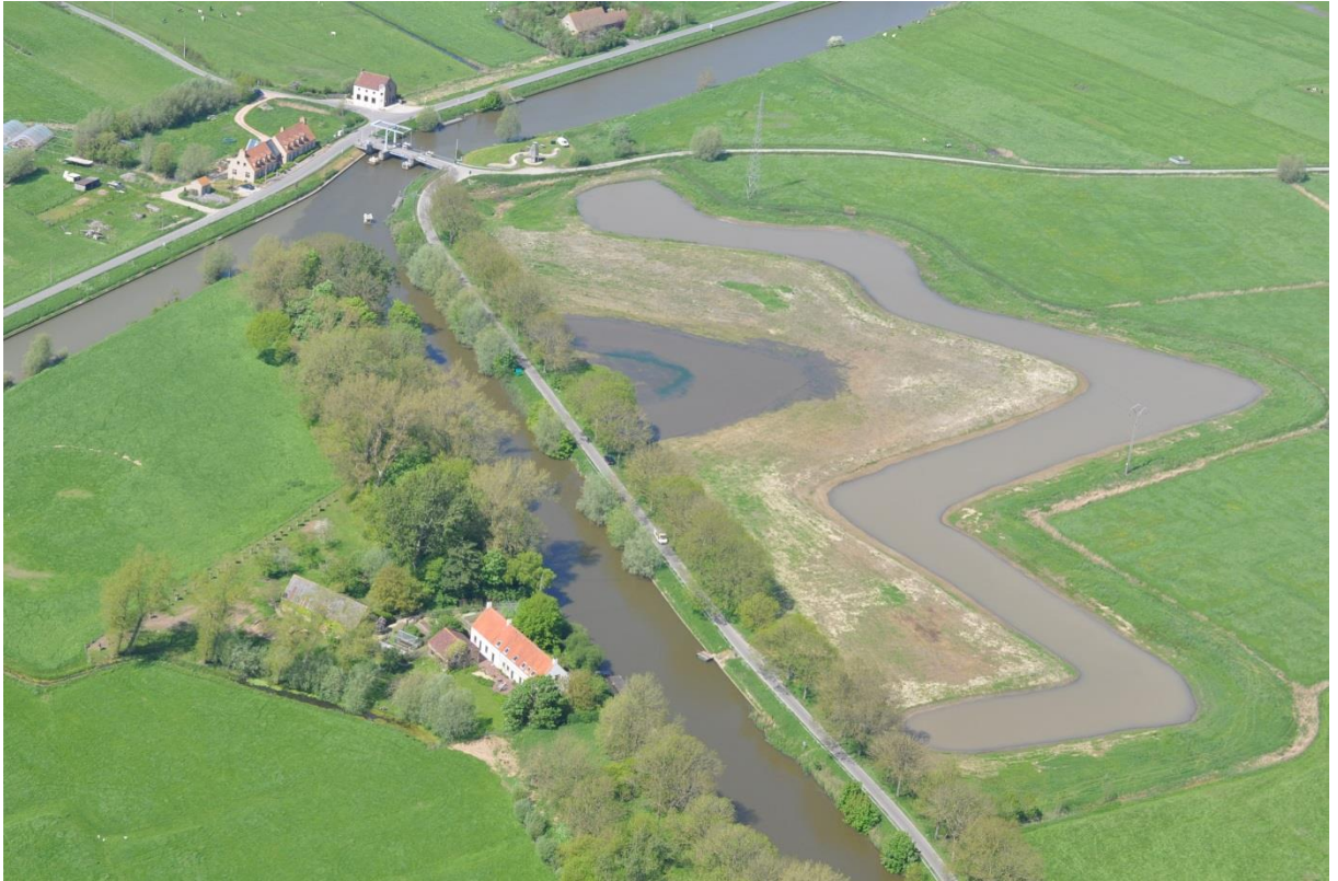
Fig. 15 Luchtfoto na uitvoering werken.
