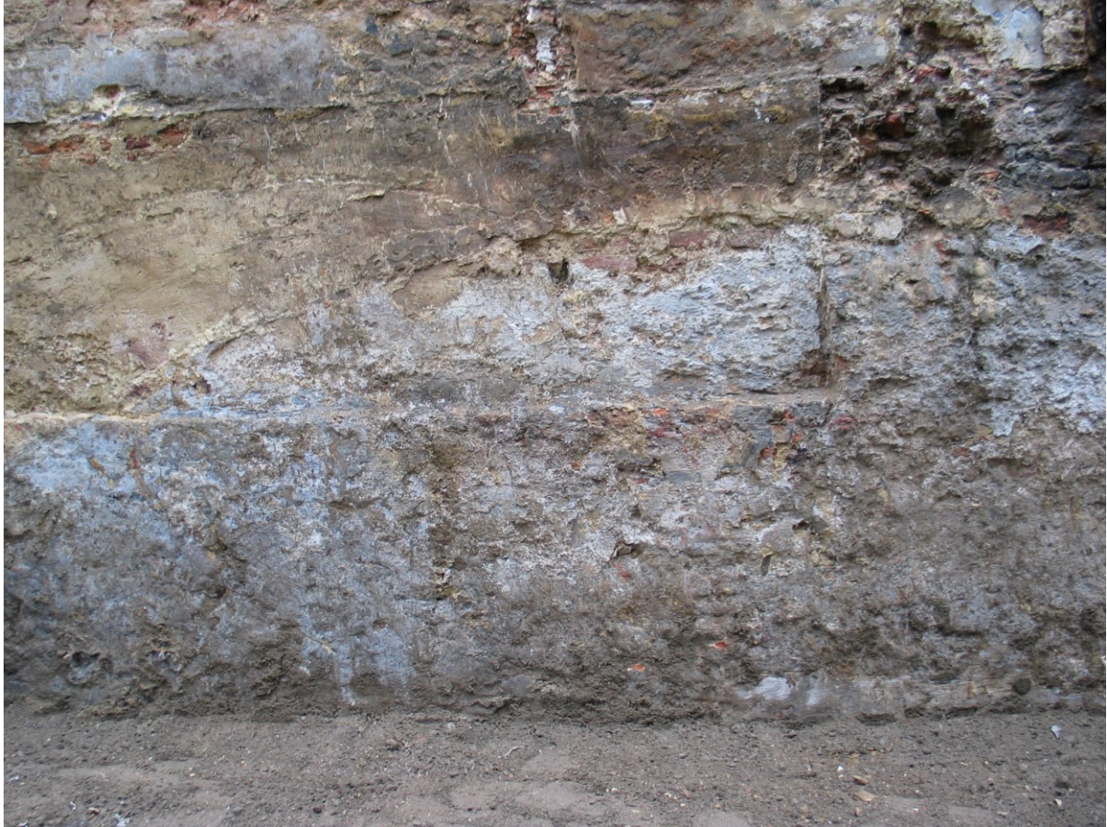
Figuur 9. Zicht op de noordelijke scheimuur ter hoogte van het achterste (meest oostelijke) keldervolume
