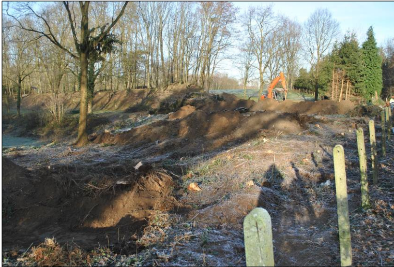
Afb. 8: Terrein na aanleg sleuven 2, 3 en 4
