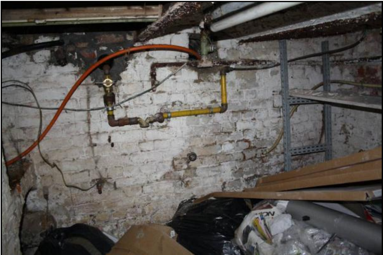
Figuur 15: Muur van de kelder onder huis nr. 48, opgetrokken in strak kruisverband.
