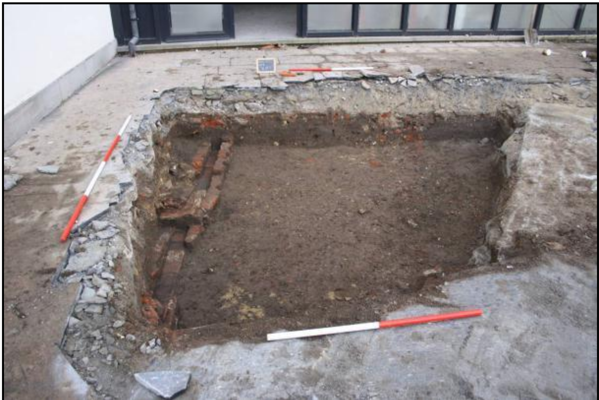
Figuur 23: Overzichtsfoto van werkput 2.
