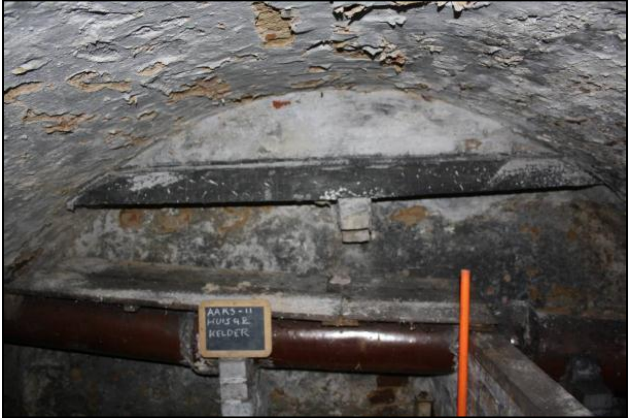
Figuur 11: Binnenaanzicht van het muurwerk en tongewelf van de kelder in huis nr. 42.
