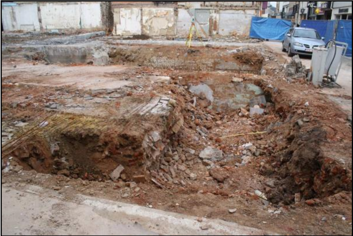
Figuur 14: Zicht op de kelders onder huizen nr. 42 en nr. 44 na de afbraak. Hier is duidelijk te zien hoe beide kelders één bouwkundig geheel vormen.
