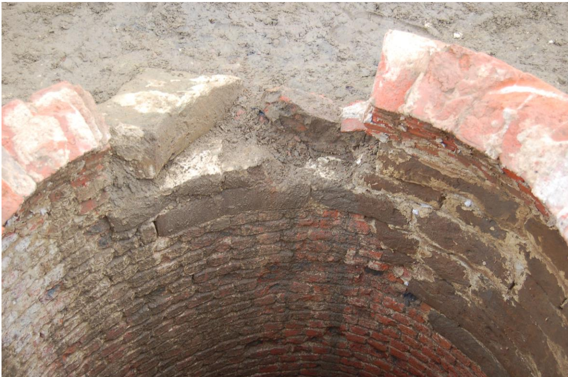
Fig.7: gebruik van ijzerzandsteen in het putlichaam.
