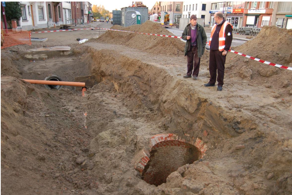
Fig 3: Toestand op het terrein na het ontdekken van de waterput.
