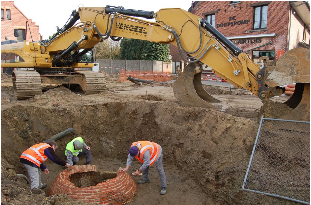
Fig.10: het opkuisen van de waterput.
