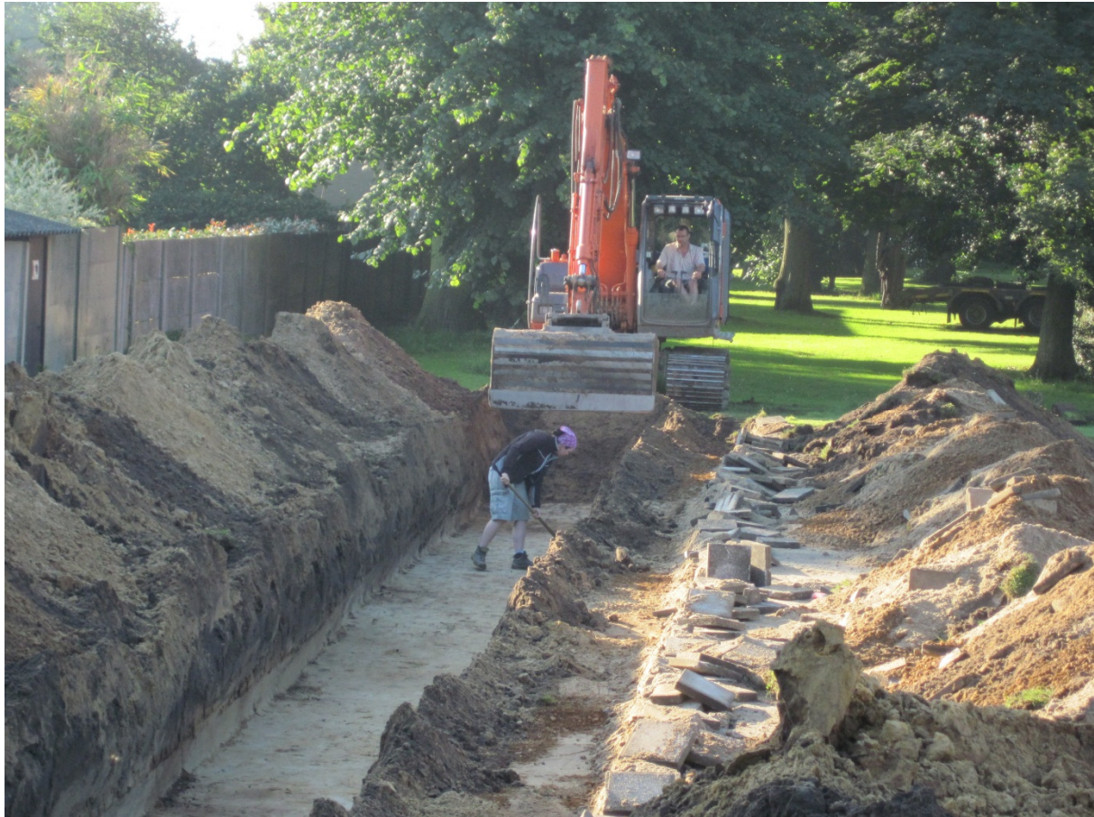
Fig. 8: Aanleg van het vlak.
