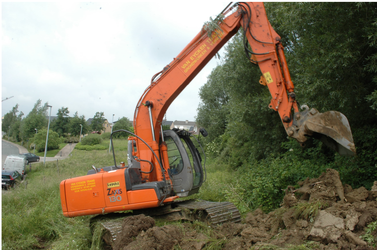
Fig. 5: Aanleg van het vlak.
