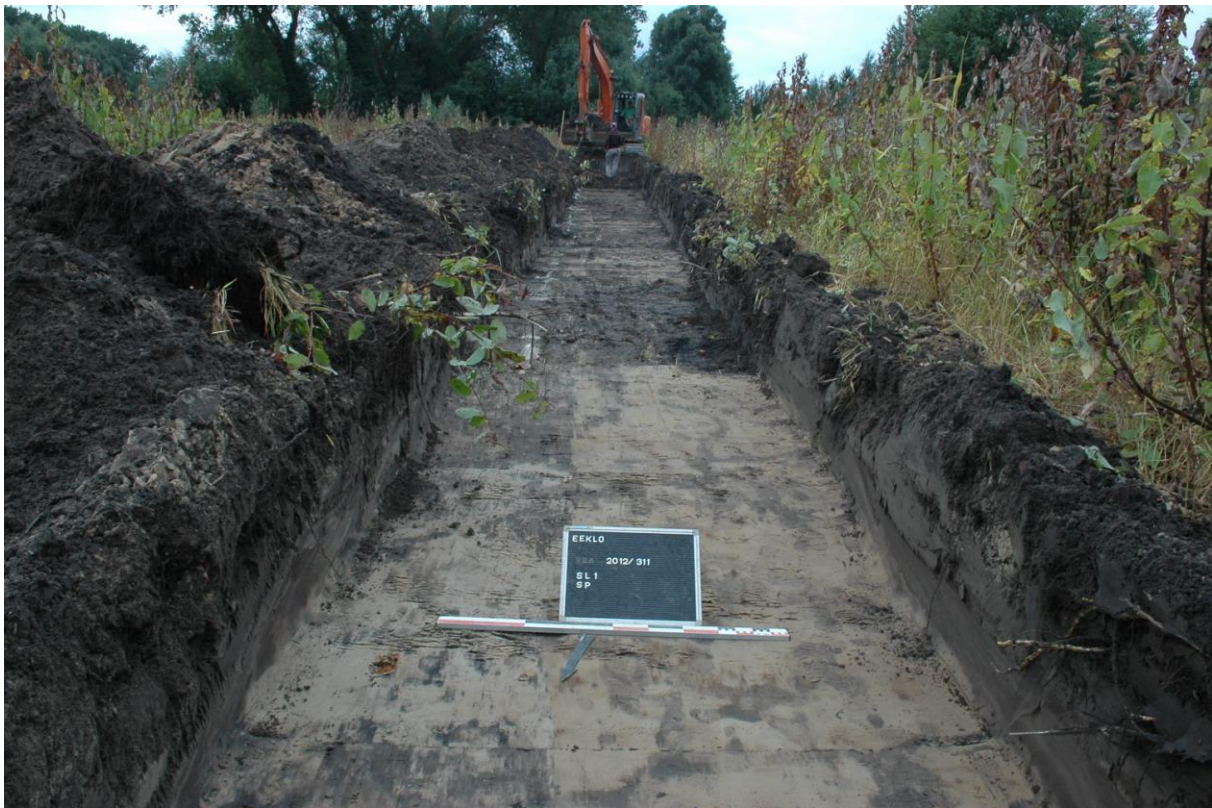
Fig. 7: Aanleg van de proefsleuven.
