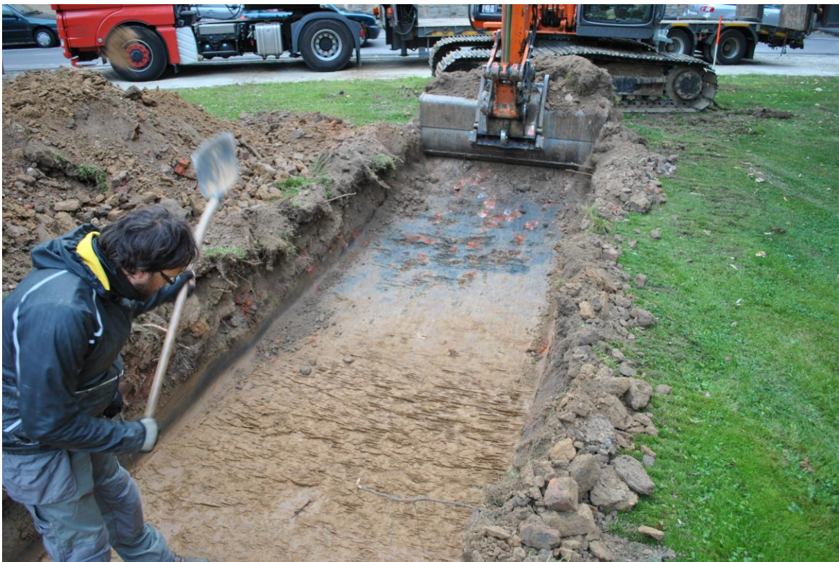
Fig. 16: Aanleg van het vlak.
