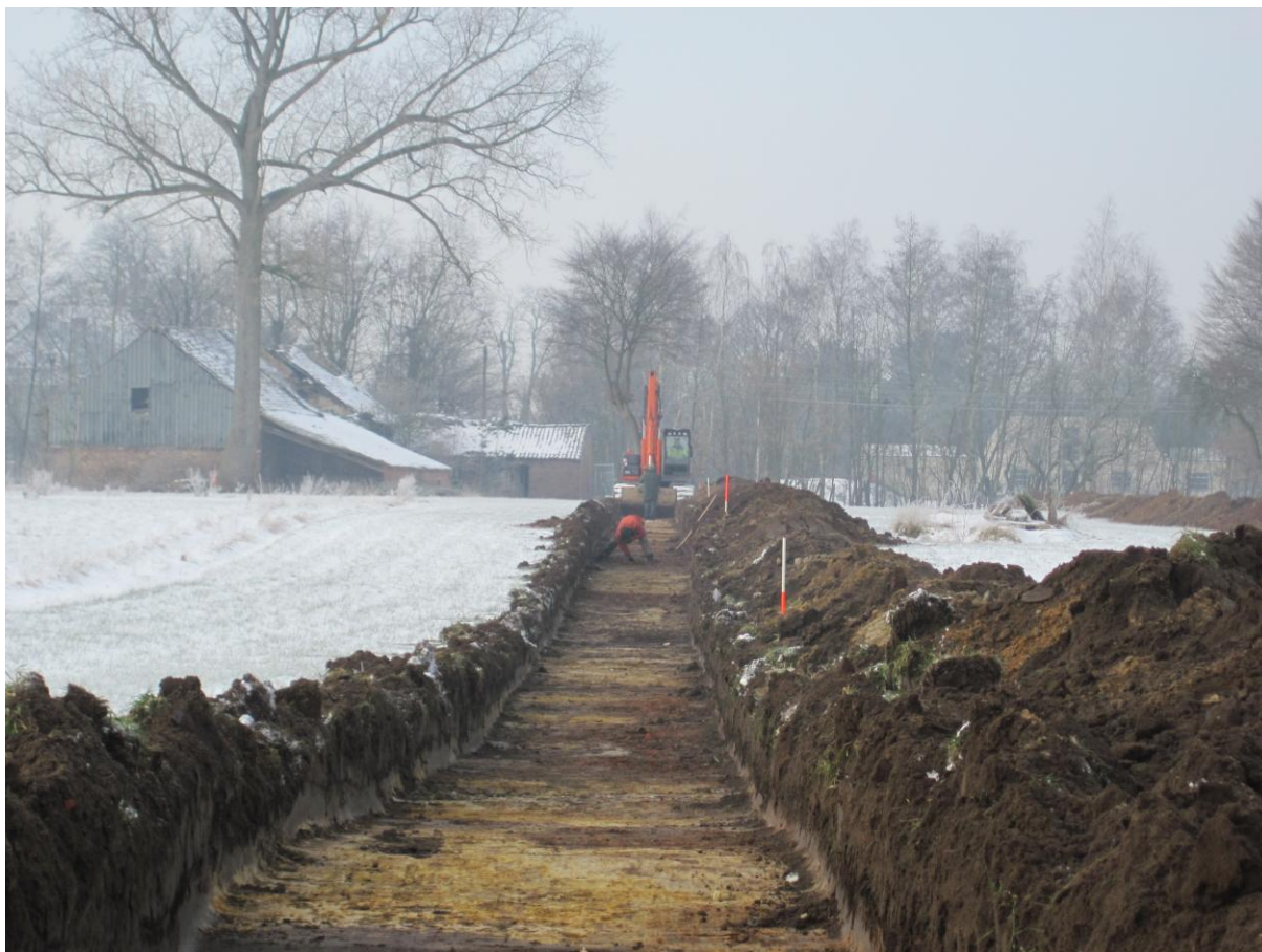
Fig. 14: Aanleg van het vlak.
