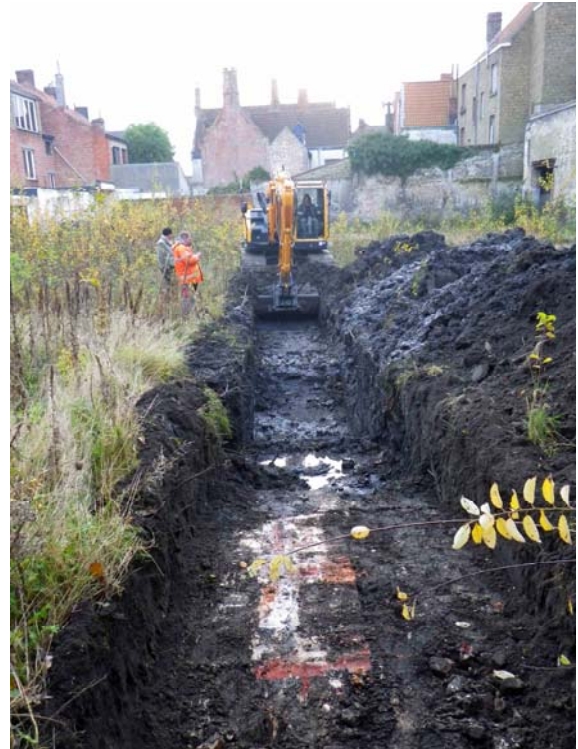
Figuur 7: Bakstenen fundering
