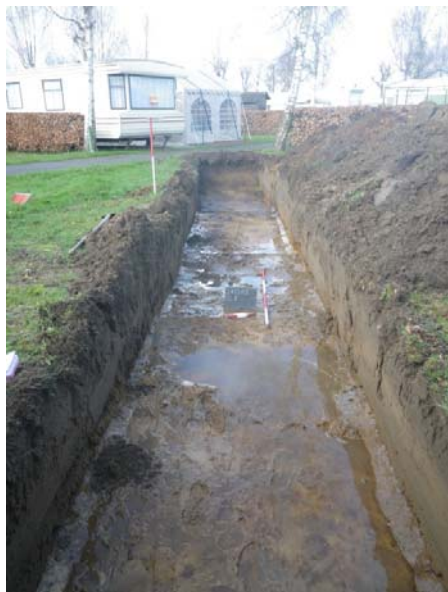
Figuur 16: Zicht op sleuf 8.
