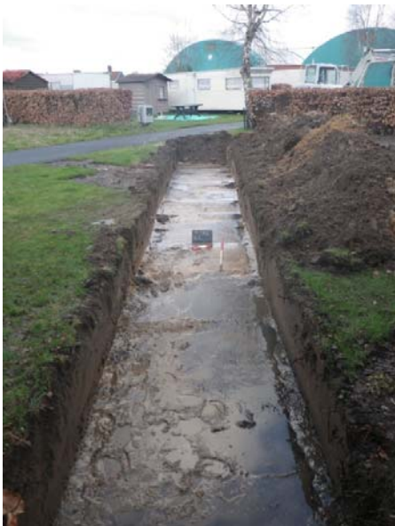
Figuur 15: Zicht op sleuf 2
