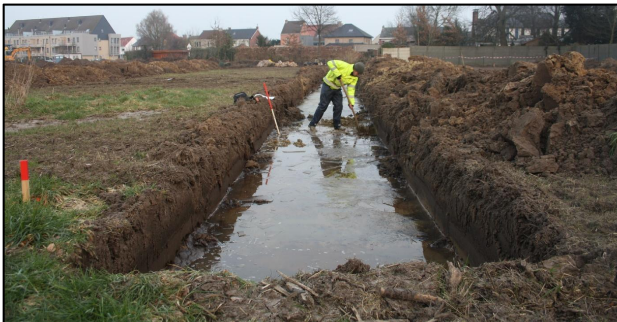
Figuur 14: Overzicht in noordelijke richting van de oostelijke zone van het plangebied met zicht op de natte ondergrond van zandleem.
