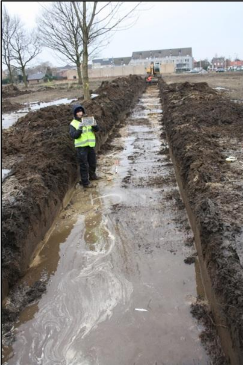
Figuur 13: Overzicht in noordwestelijke richting van de zuidelijke zone van het plangebied met zicht op de onmiddellijke inspoeling van water tijdens de aanleg van de proefsleuven.
