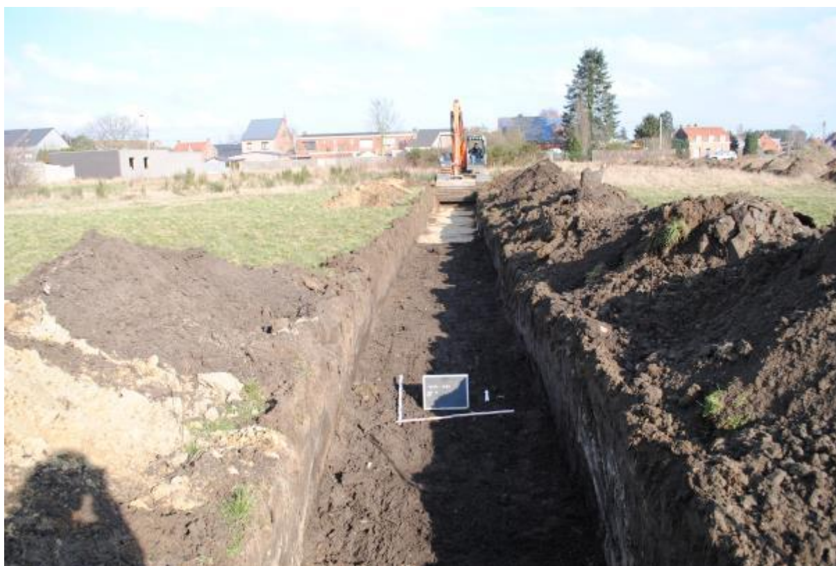
Fig. 30: De verstoring in het zuiden van sleuf 6.
