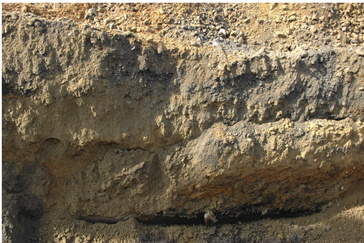
Fig. 6: Profiel met onderaan geotextiel.
