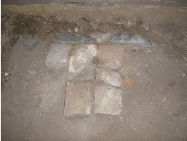
9 Fragment van een natuurstenen kerkvloer uit blauwe en witte tegels met aansluitend een aantal moefen
