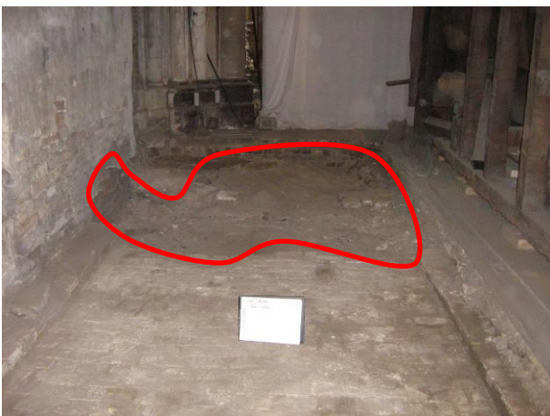
8 Uitbraak voor de aanleg van het stookkanaal en recente herstelling van de tussenmuur.
