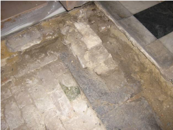
7 Bakstenen vloer met natuurstenen dorpel (noordelijke kant – zuidelijke kant van de sleuf: het niveau van de bakstenen sluit aan op het huidige vloerniveau).
