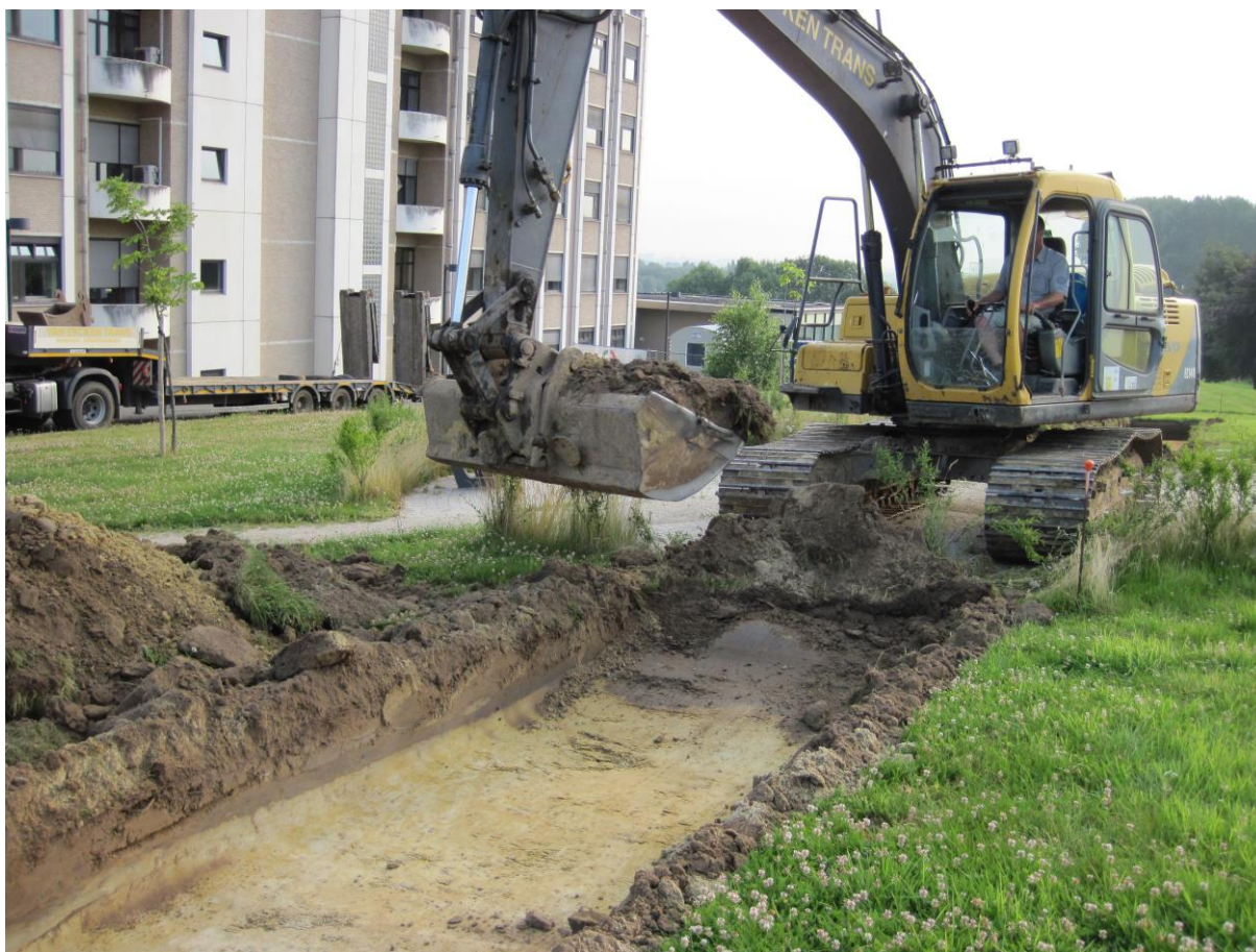
Fig. 2.1: Aanleg van het vlak.
