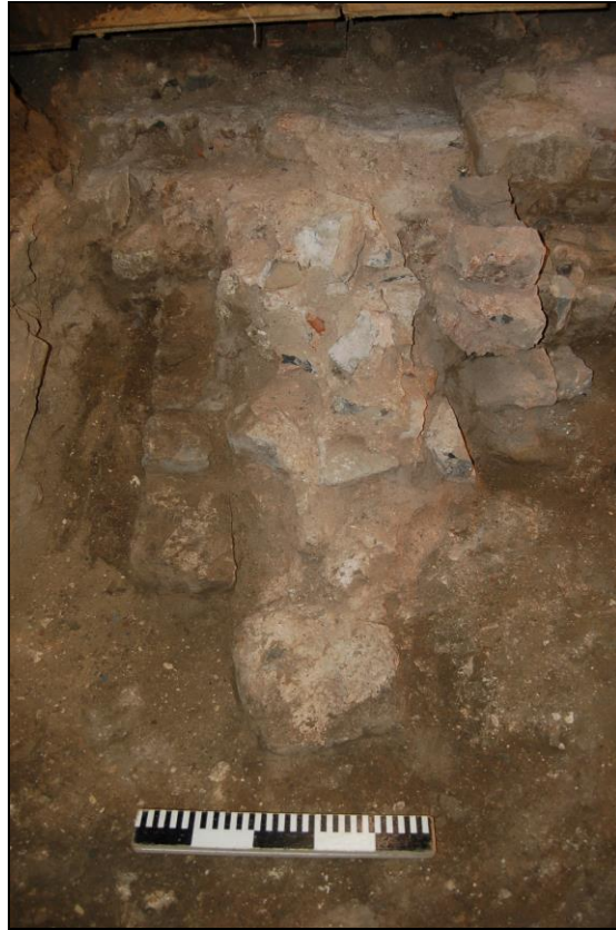
Fig. 23: fundering van de zuidelijke buitenmuur van de Gotische sacristie met een kern van de muur in silex en roze kalkmortel.
