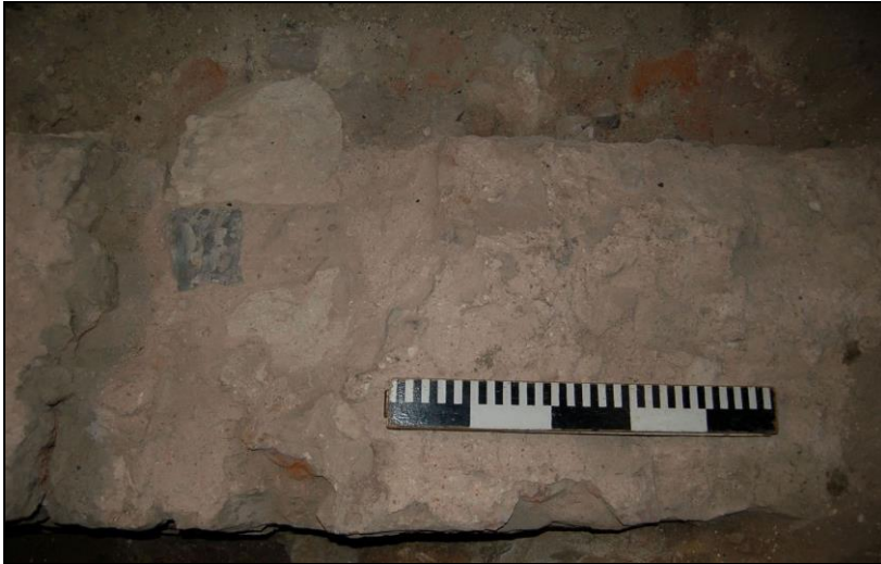
Fig. 8: muur opgebouwd uit roze mortel en silex.
