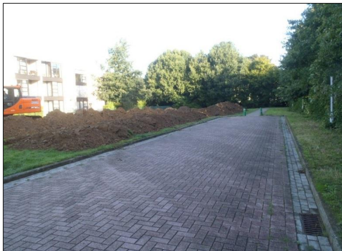
Figuur 4: Aanleg van noord-zuid georiënteerde sleuven.
