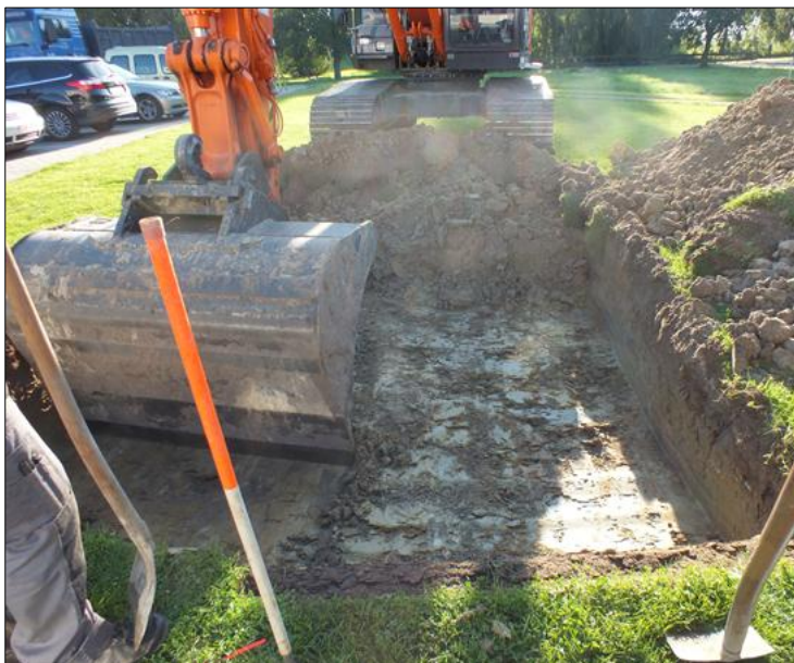
Figuur 8: Aanleg van de sleuven.
