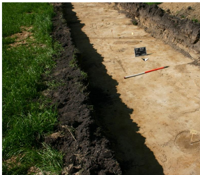
Figuur 3.9. Overzicht van enkele paalkuilen en een wandgreppel van een gebouw in proefsleuf wp1
