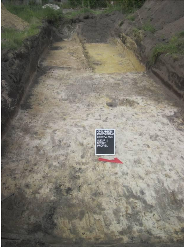
Proefsleuf 4: een opmerkelijk verschil in bodemstructuur én textuur met de bodem in de proefsleuven 1, 2 en 3
