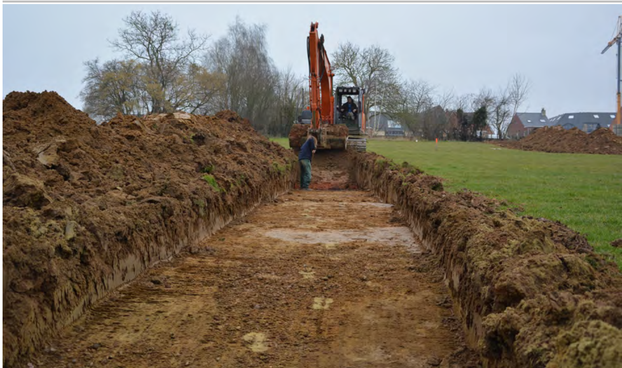
Fig. 2.1: Aanleg van het vlak.
