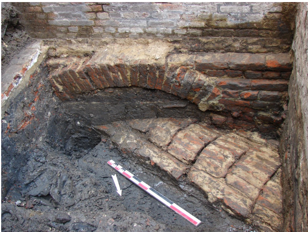
Fig. 14 Baksteenriool wordt gesneden door spaarboogfundering.
