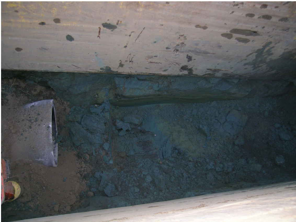
Fig 4: Glauconietrijk zand op de bodem van de sleufbak op een diepte van ca. 6m
