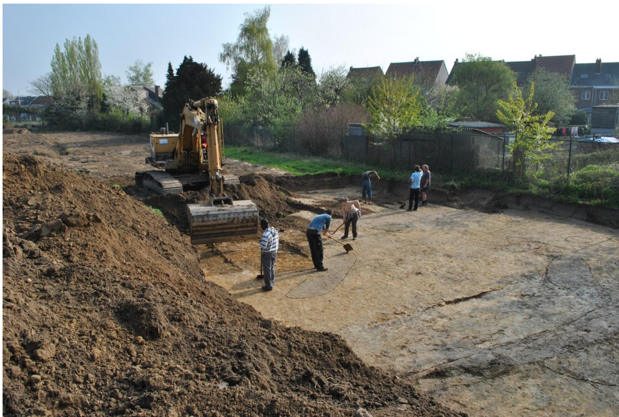
Fig. 2.2: Het opschaven van de aangelegde werkputten en het inkrassen van sporen.
