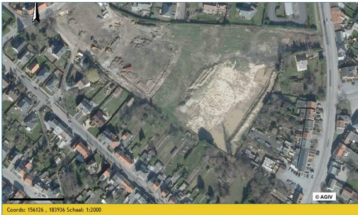
Fig. 3.3 Luchtfoto waarop het opgravingsvlak te zien is.
