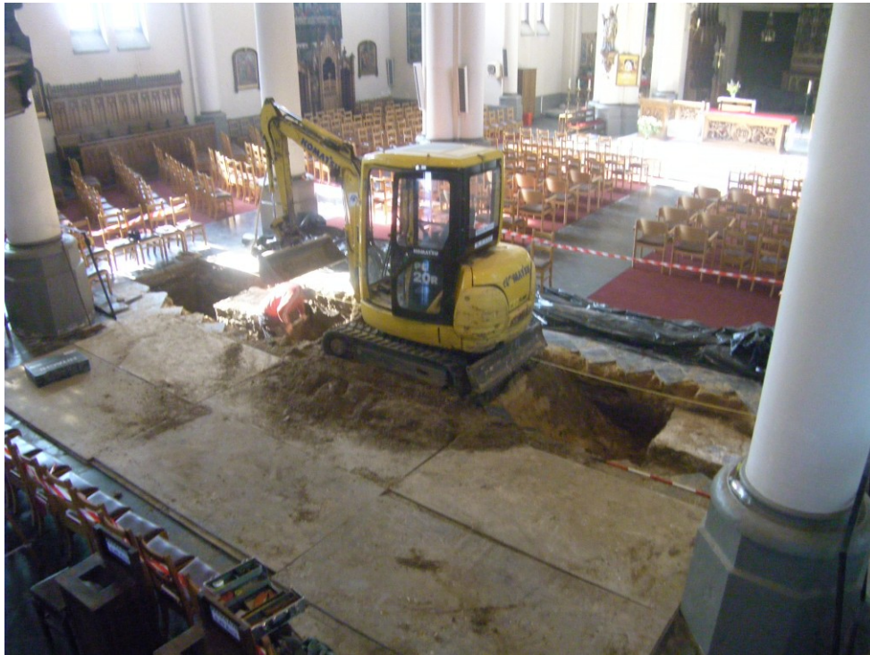
Zicht op de sleuf vanuit het noordoosten.
