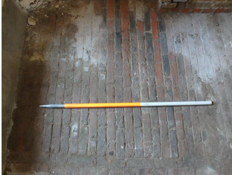
Figuur 15: Een deel van de vloer in de kelderruimte van het Heksenkot (ARCHEBO bvba, 2016).
