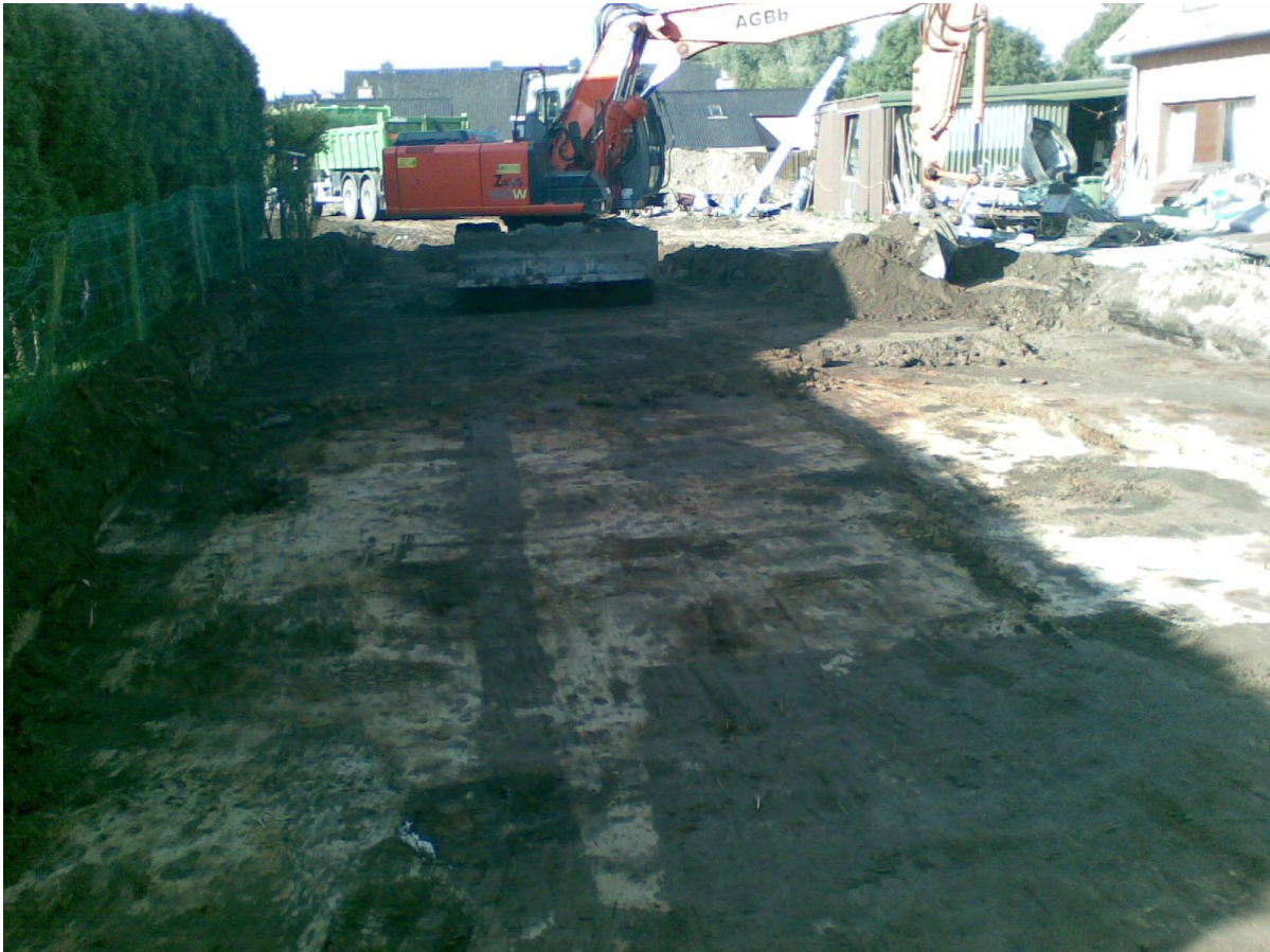
Foto 2: Beeld op de afgraving van de oostelijke arm van het wegtracé met recente steringen.
