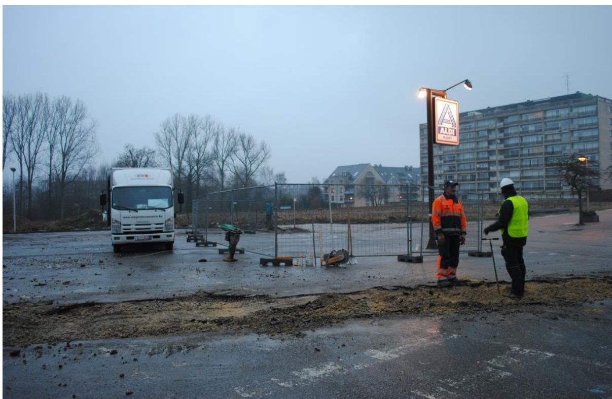
Fig. 5: De asfaltlaag in het oosten is verwijderd voor de sleuf van riool 1. Er werd een poging gedaan om met een edelmanboor een eerste indruk van het profiel te krijgen. De aangevoerde grond met grind bleek niet doordringbaar te zijn.
