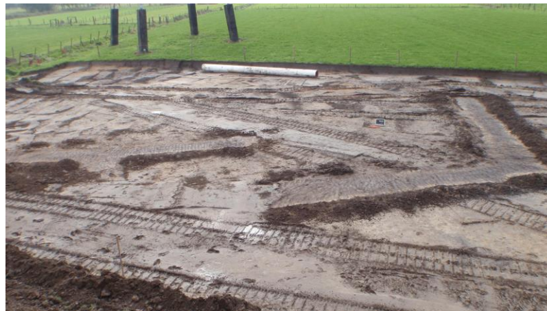
Afbeelding 20: Grachtstructuur aan hoogspanningsmast
