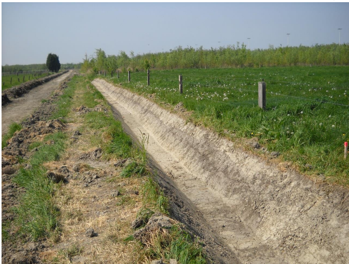
Fig. 7 Overzicht van de naastliggende gracht. In deze gracht is duidelijk een ophogingspakket zichtbaar (zone tussen profiel 1 en profiel 2).
