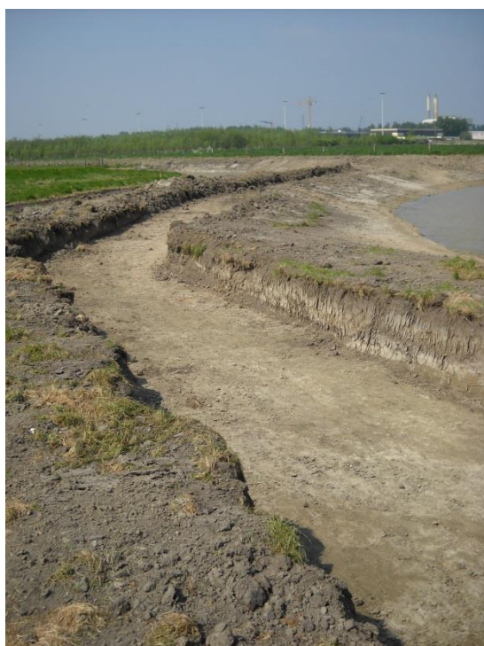
Fig. 15 Zicht op het cunet van het fietspad en de speelkom.
