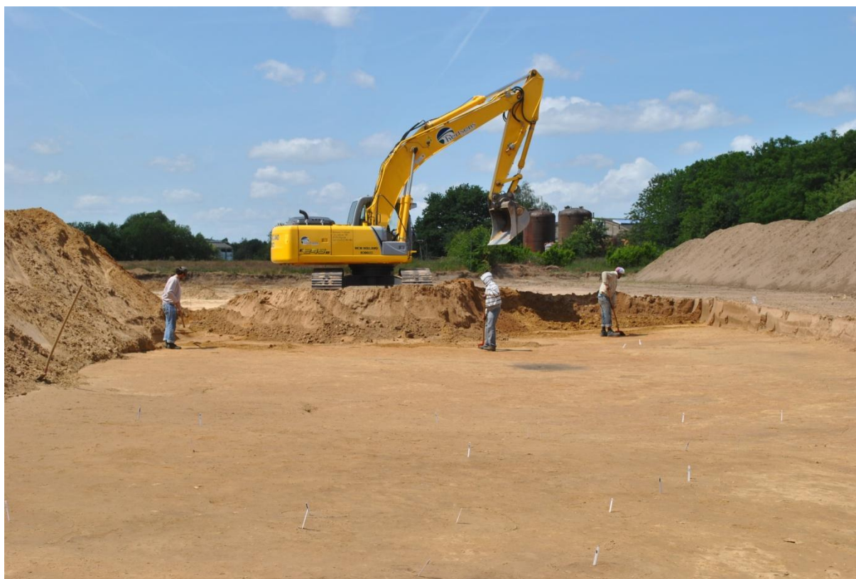
Fig. 11: Aanlag van werkput 2 met de kraan.
