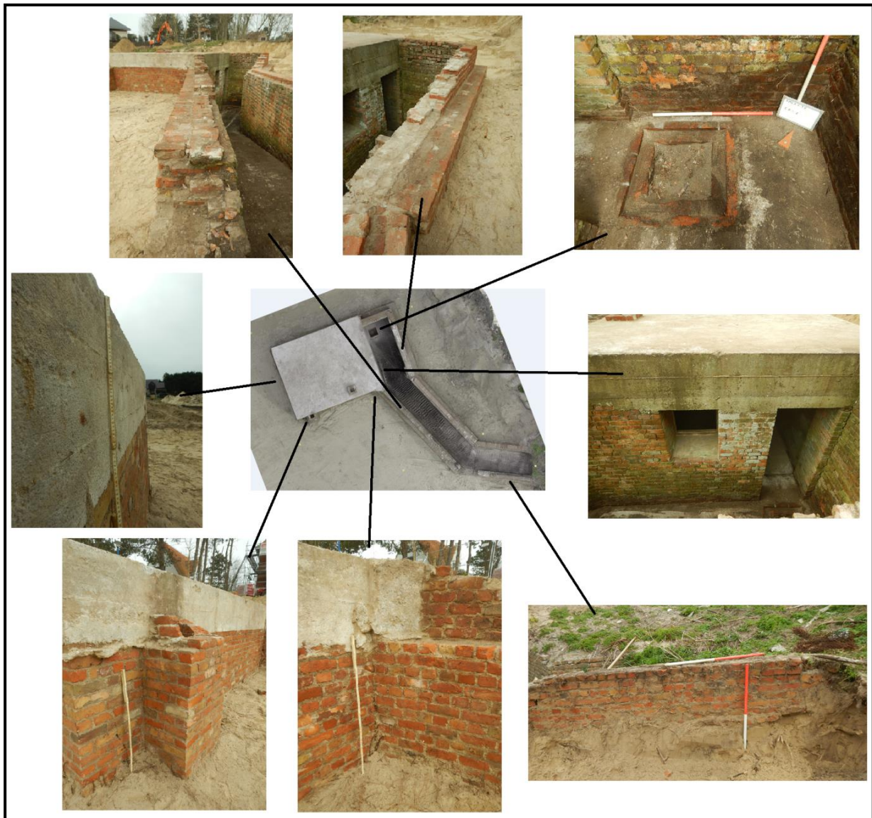
Figuur 42: Collage structuur 1; externe elementen, bouwnaden en muurdetails.
