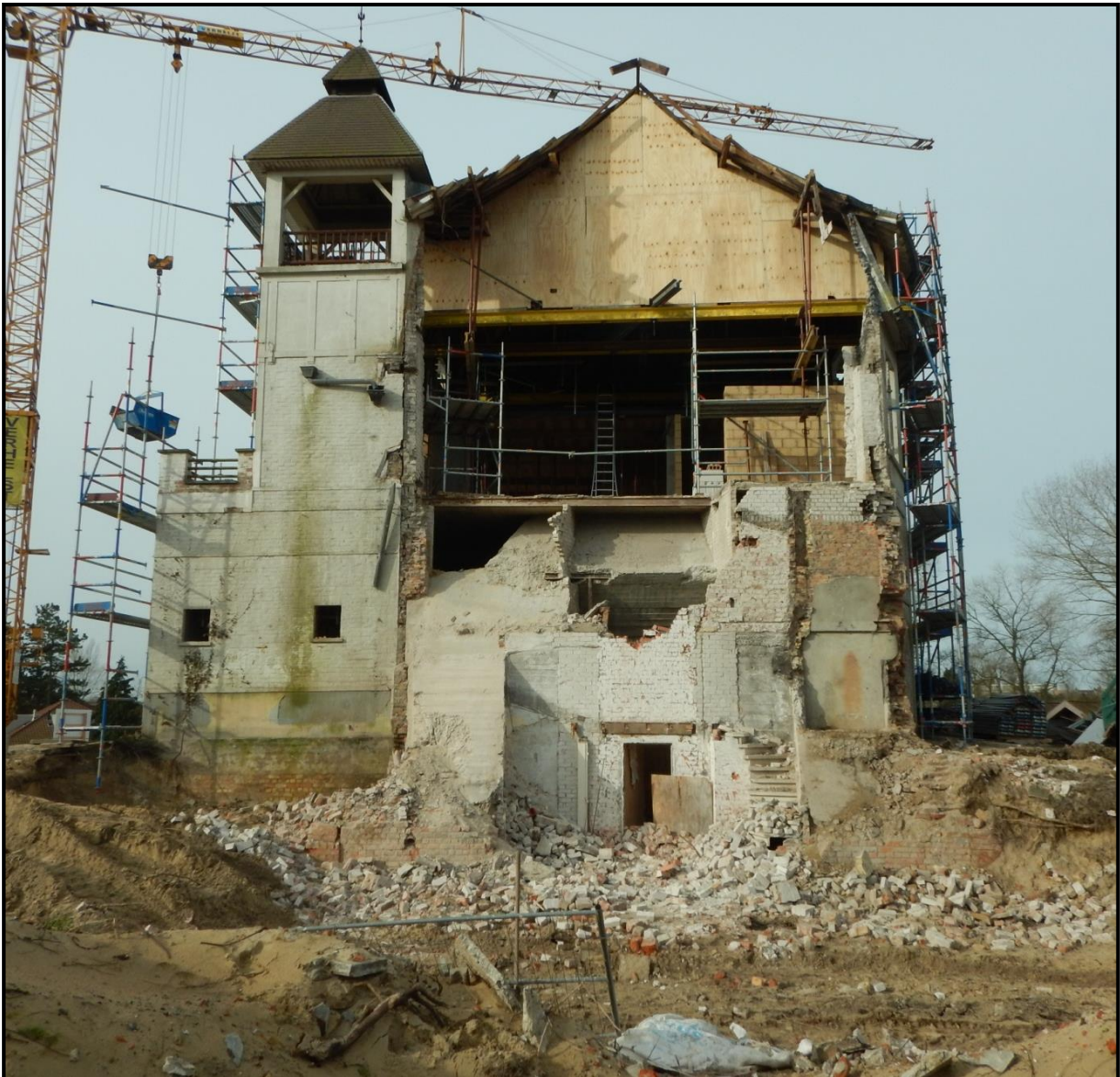
Figuur 19: Zicht op hedendaagse renovatiewerken met vooraan de betonnen wanden van de artilleriebunker ingewerkt in de villa 'La Vigie' (foto met zicht op de frontzijde van waaruit gevuurd werd in de richting van Lombardzijde).
