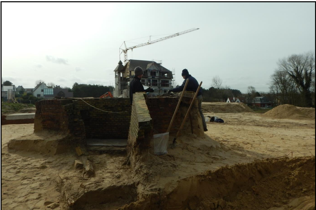
Figuur 28: Optekenen van de bouwtechnische elementen van de Duitse geschutstelling.
