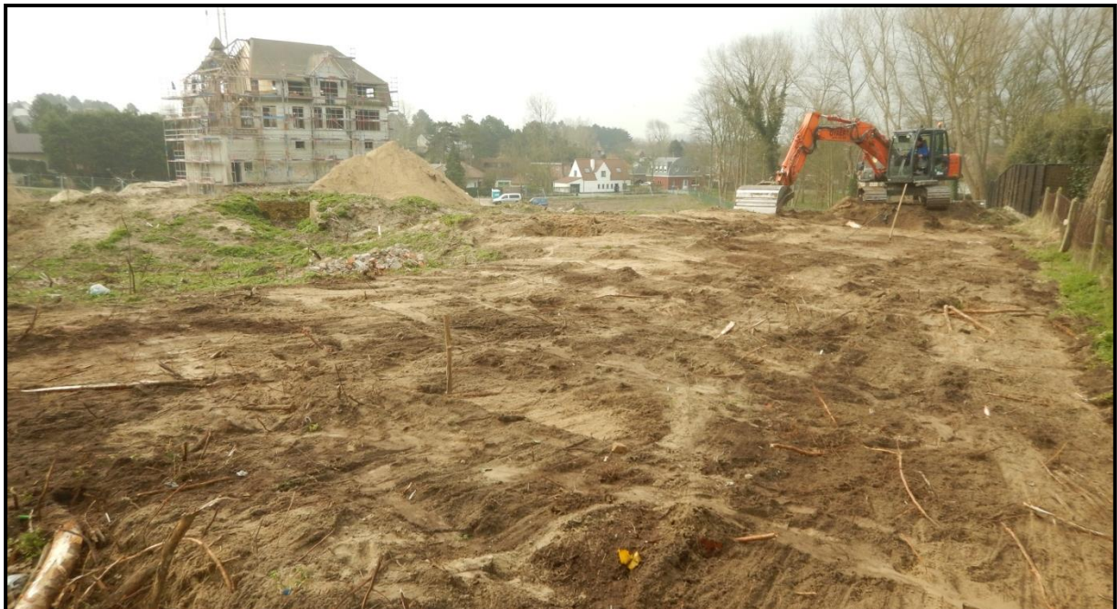
Figuur 26: Zicht op het verwijderen van de toplaag tot het tweede metaaldetectieniveau.
