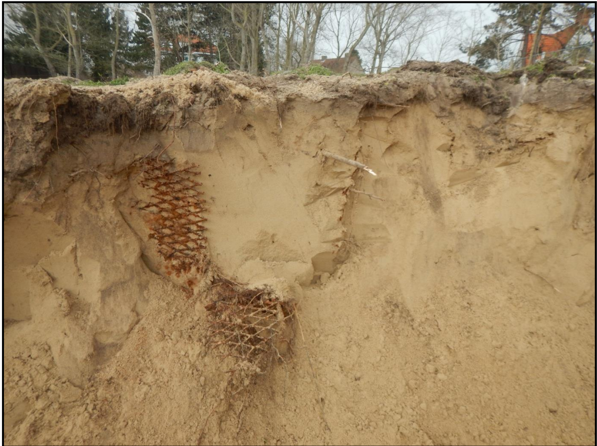
Figuur 35: Zicht op de profielopbouw met bovenaan het dunne organische laagje met daaronder het gelige duinzand. In het profiel zijn tevens de resten te zien van trenchrevetten (ijzeren raster in ruitpatroon ter versterking van onder andere loopgraafwanden).
