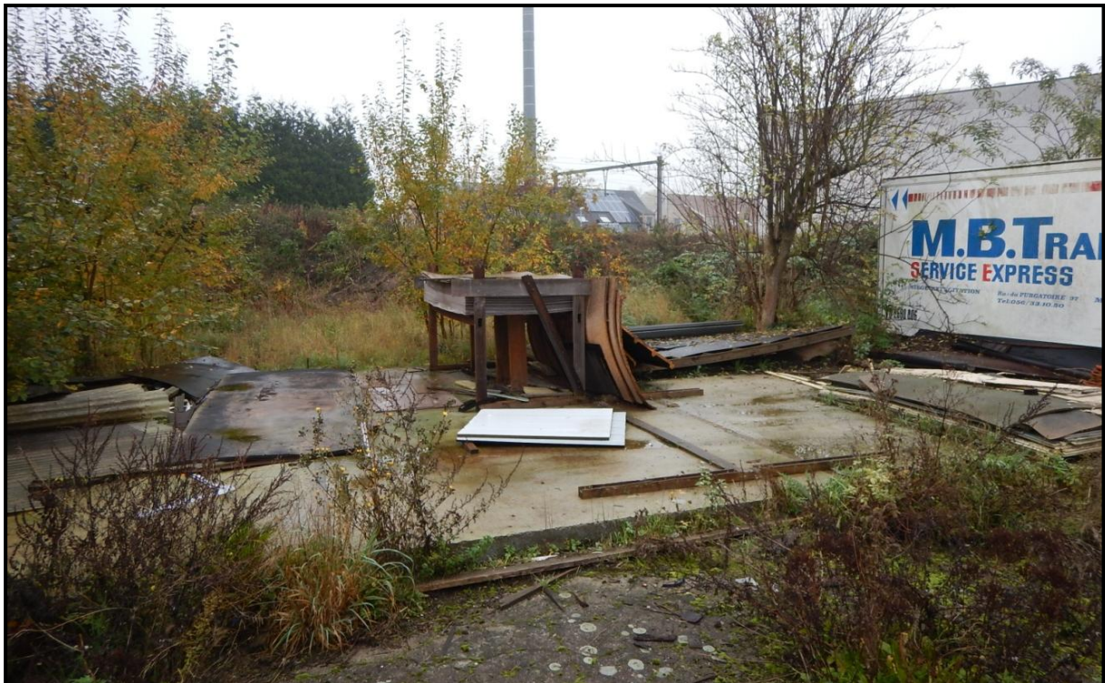
Figuur 10: Zicht op de betonplaat en de metalen container centraal in de onderzoekszone.
