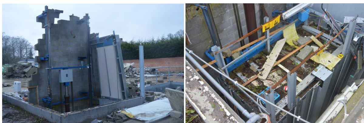
Fig. 2.2: De verstoorde zone met ingegraven liftkoker en kelder.
